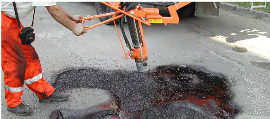
Рис.7. Укладка смеси в выбоину
