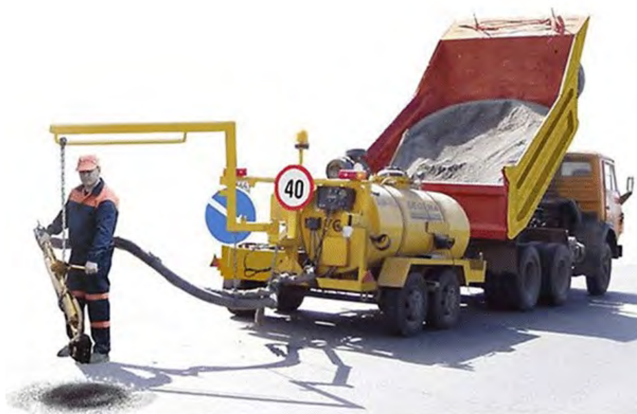
Рис.5. Схема ремонта асфальтобетонных покрытий струйно-инъекционным методом
