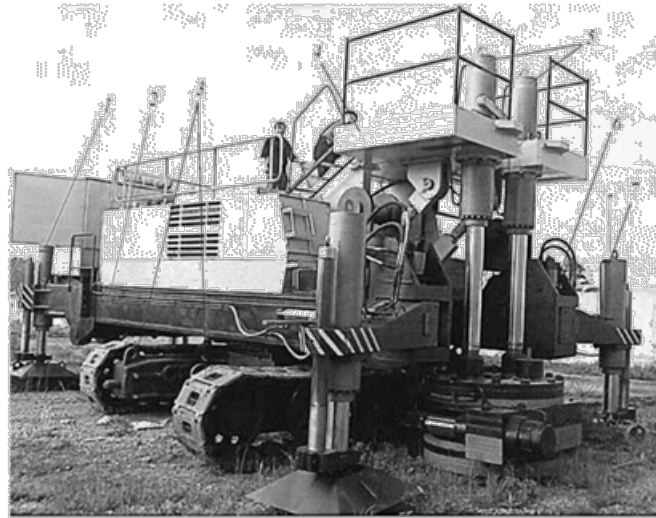
Рис.3. Установка вдавливания свай УСВ 160:
