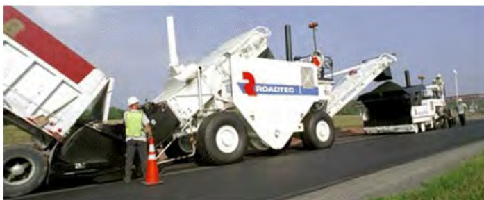
Рис.11. Перегрузка асфальтобетонной смеси в асфальтоукладчик
