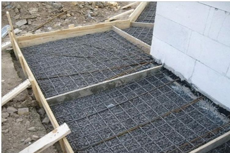
Рис. 11. Готовая к бетонированию опалубка с арматурным каркасом
