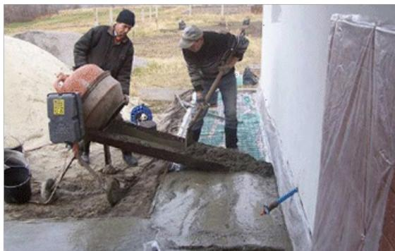
Рис.13. Подача бетонной смеси в опалубку
