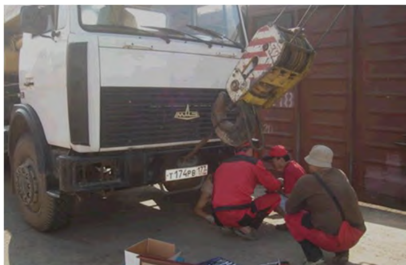
Рис.2-3. Снятие навесных элементов и оборудования
