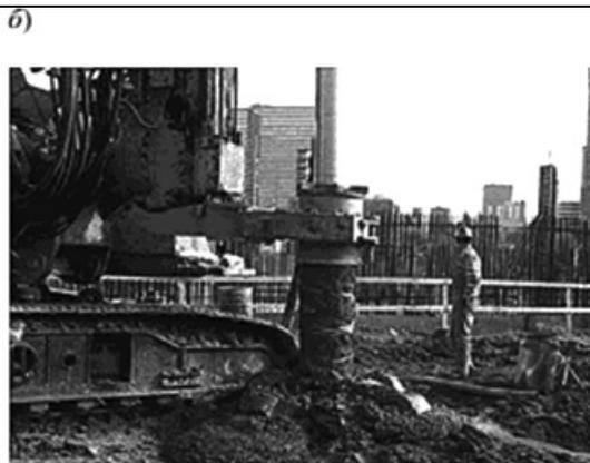
Рис.3. Установка, реализующая набивную технологию вытеснения:
