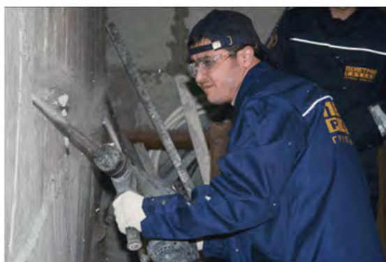
Рис.2. Удаление слабого бетона
