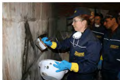
Рис.3. Нанесение раствора из материала "Скрепа М500 Ремонтная"
