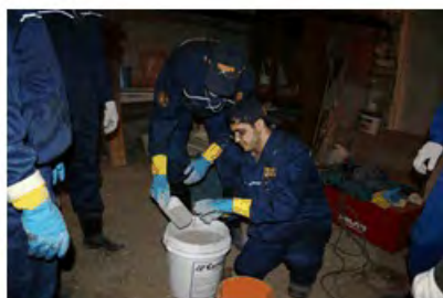
Рис.6. Ручное смешивание сухой смеси "Скрепа М600 инъекционная"
