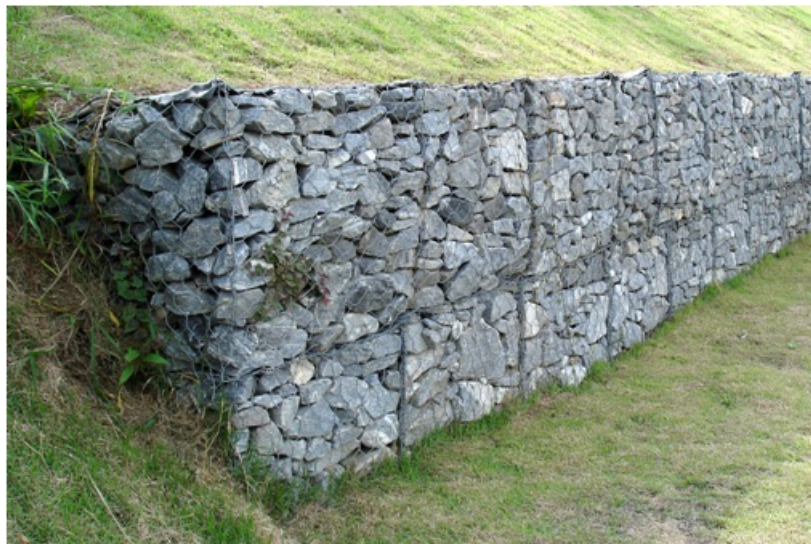
Рис.3. Подпорная стенка из габионов
