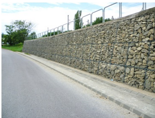
Рис.9. Подпорная стенка вдоль автодороги
