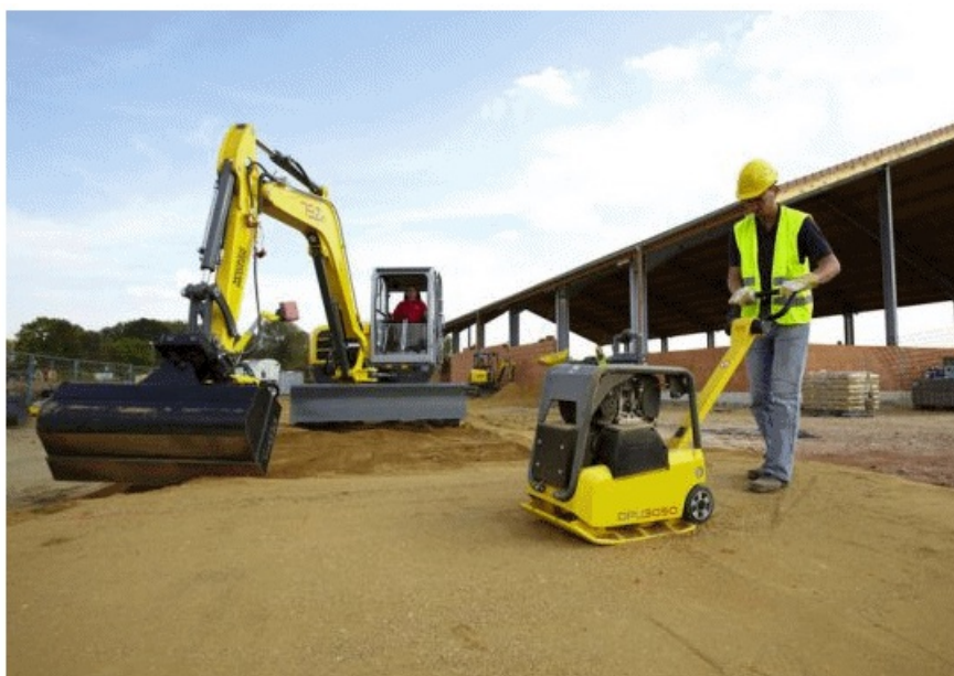
Рис.3. Возведение дренажной подушки под основание зданий
