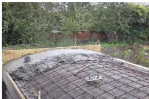
Рис.14. Формирование бетонной поверхности
