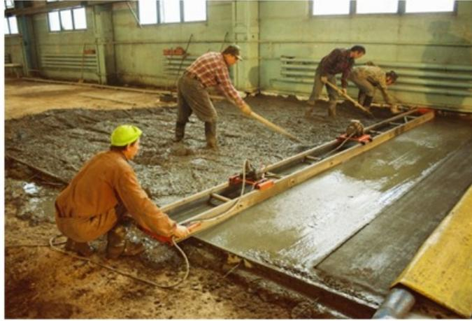
Рис.15. Процесс бетонирования
