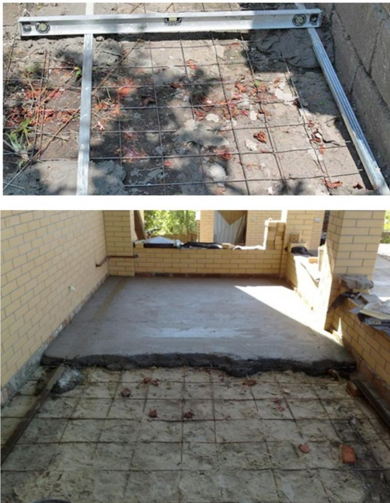
Рис.12-13. Армирование поверхности
