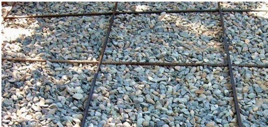
Рис.5. Армирование поверхности
