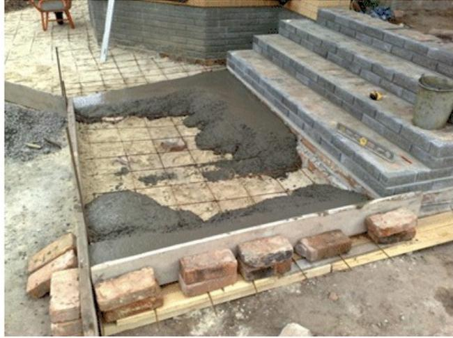
Рис.1-2. Формирование наклонной поверхности из бетона
