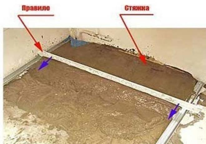
Рис.9. Выравнивание поверхности после заливки полужидким раствором
