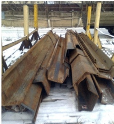
Рис.15. Складирование шпунта
