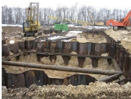
Рис.18. Схема ограждения котлована
