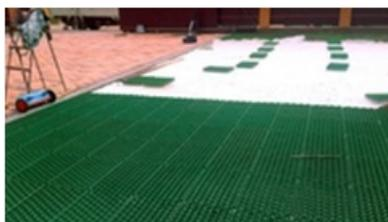
Рис.15-16. Укладка газонных решеток
