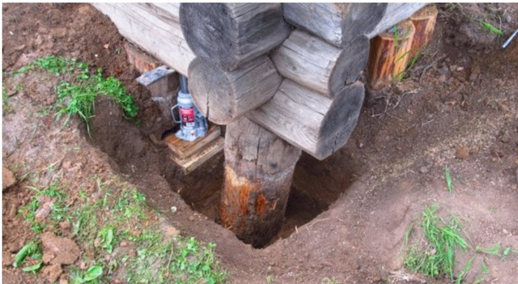
Рис.8. Отрытая угловая свая дома готовая к реконструкции
