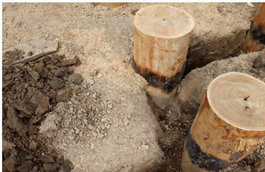
Рис.4. Фундамент из древесины, прошедшей процесс обугливания
