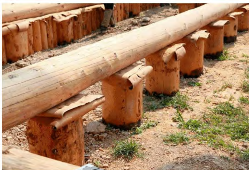
Рис.1. Деревянный фундамент
