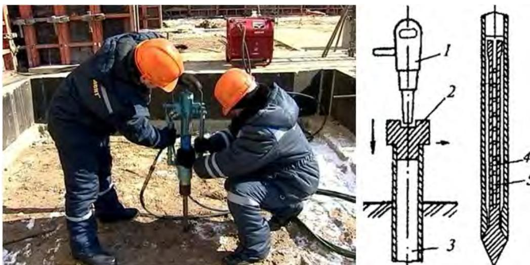
Рис.14. Погружение инъектора в грунт
