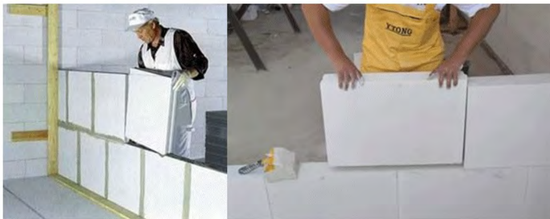
Рис.16. Общий вид установки мелкогабаритных гипсовых плит
