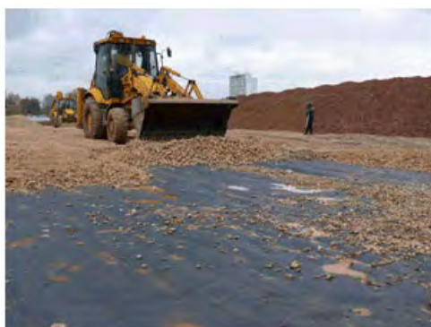
Рис.13-14. Засыпка грунтом геотекстиля
