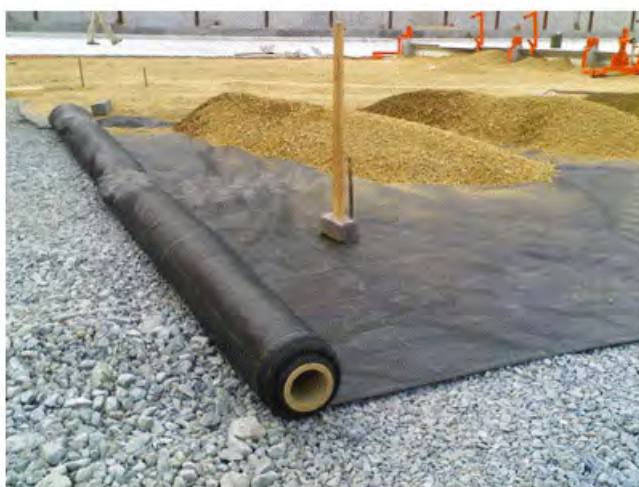
Рис.5-6. "Геоспан ТН" предотвращает взаимопроникновение материалов, контактирующих в разделительных и технологических прослойках
