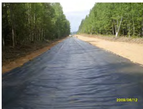
Рис.10. Продольная укладка геотекстиля
