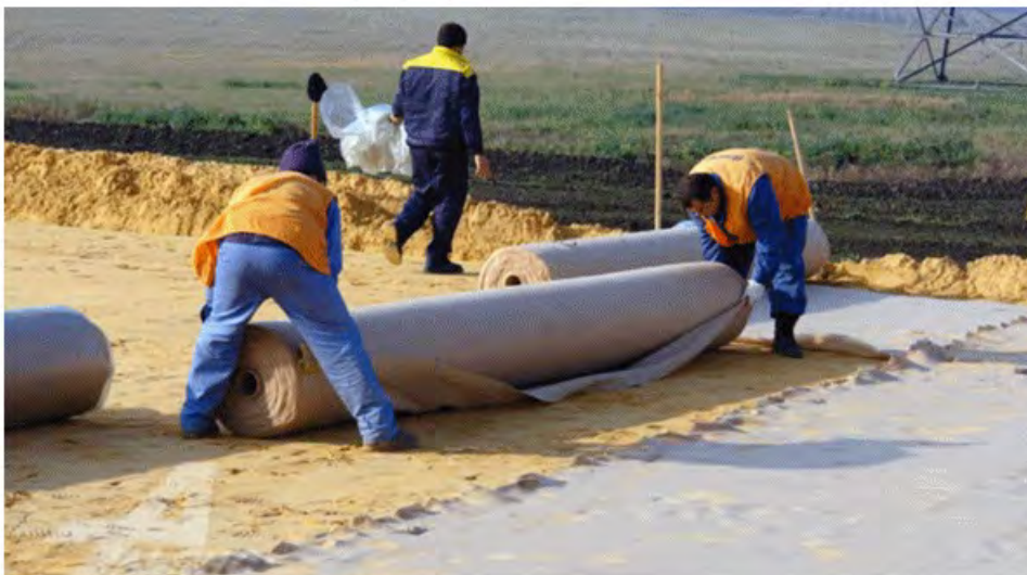
Рис.11. Раскатка рулона геотекстиля
