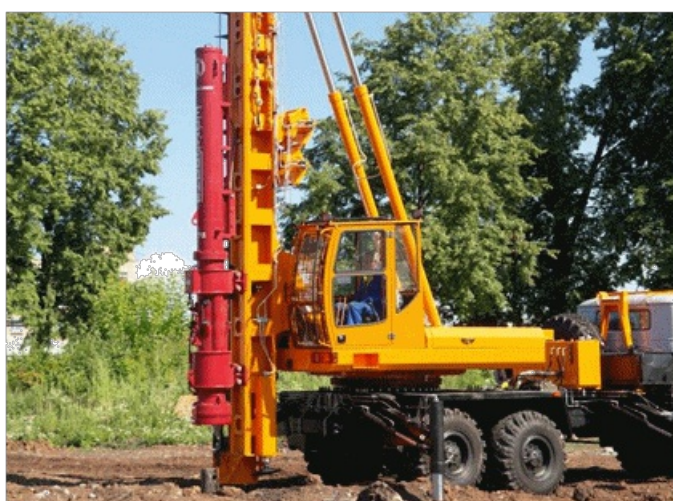
Рис.15. Забивка свай-опор бурильно-сваебойной машины БМ-811
