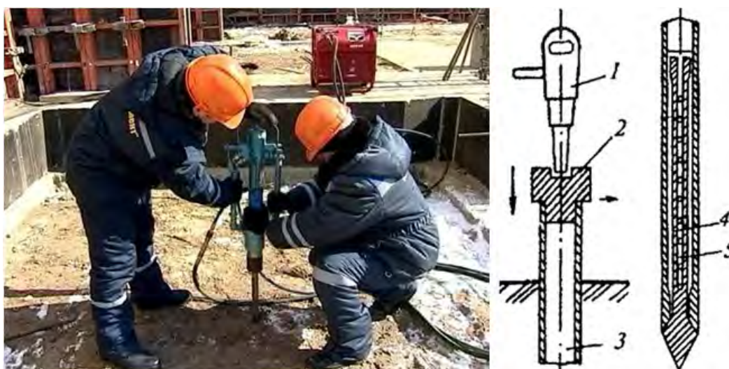
Рис.12. Погружение иньектора в грунт
