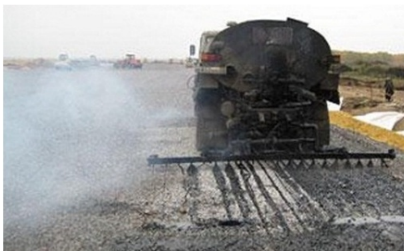
Рис.13. Подгрунтовка основания
