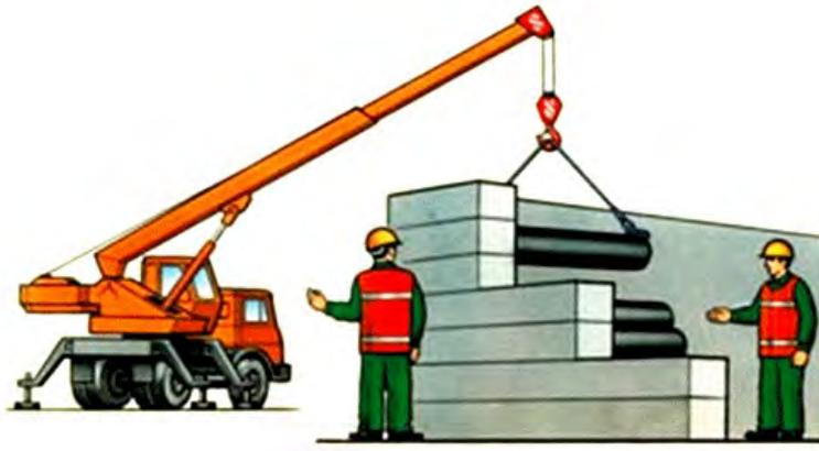
Рис.22. Передача сигналов в ограниченной зоне видимости
