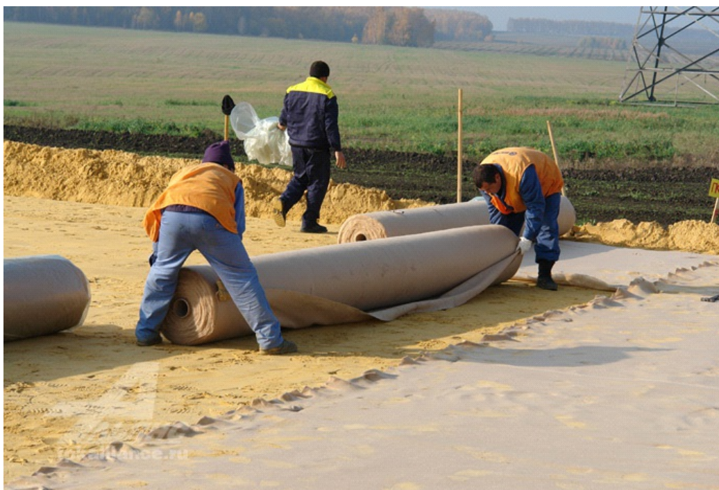
Рис.12. Укладка геотекстиля на подготовленную поверхность.
