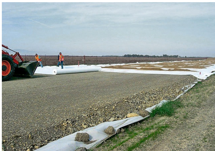
Рис.18. Устройство насыпи поверх обоймы.
