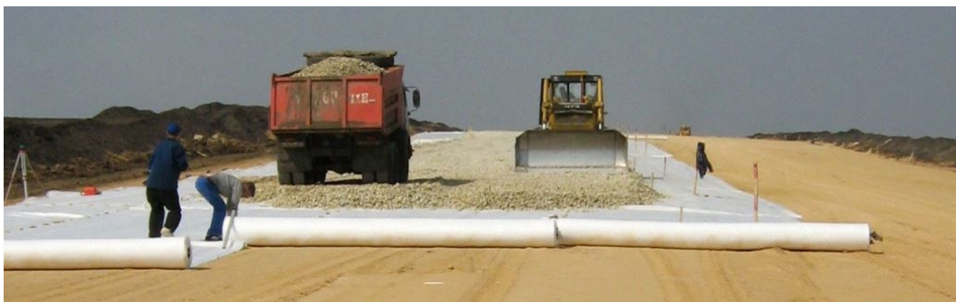
Рис.14. Завоз и разравнивание грунта
