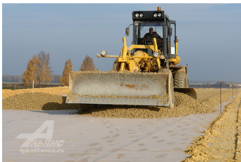
Рис.16. Планирование грунта автогрейдером
