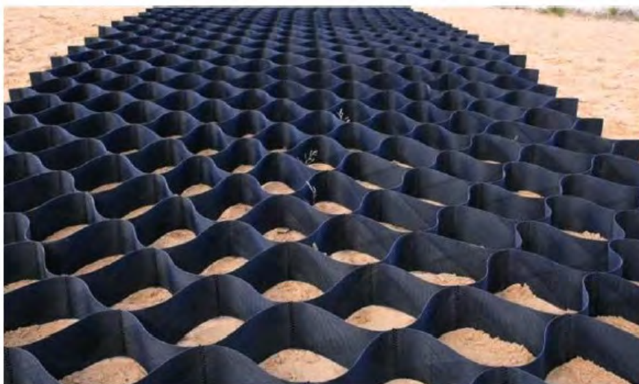
Рис.16. Уложенная георешетка готовая для заполнения песчано-гравийной смесью
