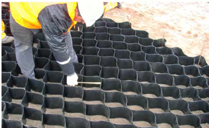
Рис.15. Проверка правильности укладки секций георешетки
